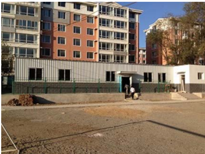
小学校敷地内。全機器建屋内に設置。
