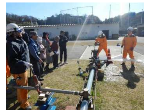
本邦研修(漏水修理実演)
