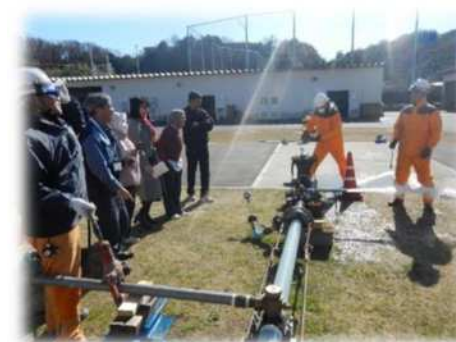
本邦研修(漏水修理実演)
